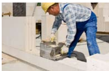
Mit einem speziellen Dünnbettmörtel, werden die Lager- und Stoßfugen vermörtelt
