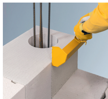
Figur 2: Mørtel i studsfuge
