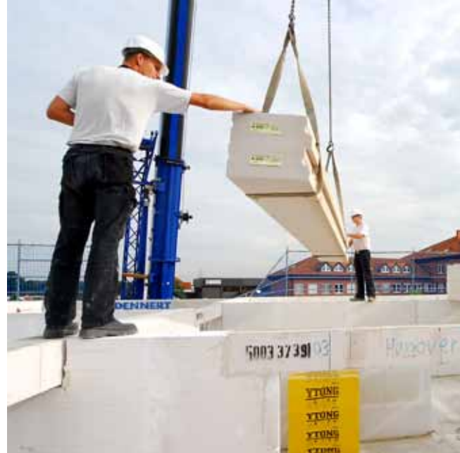
Det massive tag af Ytong Tagelementer beskytter mod sommervarmen og beskytter bygningen mod overophedning fra solen.
