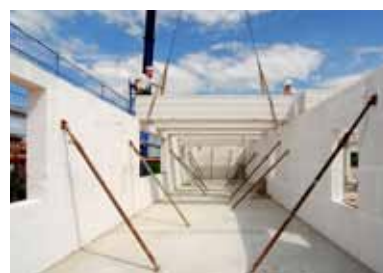
Vægelementerne projekteres og fabriksfremstilles enkeltvis, præcist på mål. Den computerstyrede produktion garanterer en ensartet, høj kvalitet.
