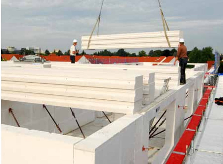
Taget blev udført som massivtag med Ytong Tagelementer, som fremskyndede det videre byggeforløb.
