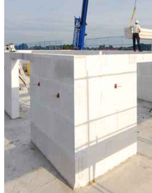
Med vægelementer af porebeton kunne byggeforløbet optimeres og byggetiden nedbringes.
