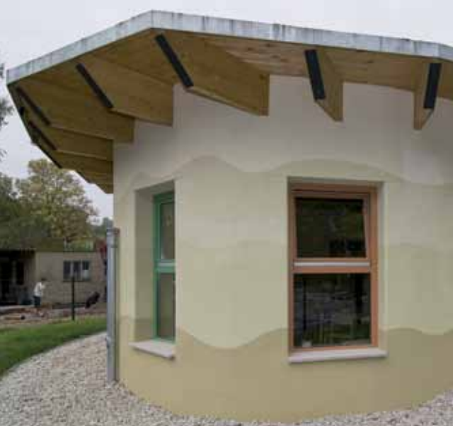
Den fordringsfulde grundplan med mange fremspring og rundinger udføres perfekt med Ytong porebeton.
