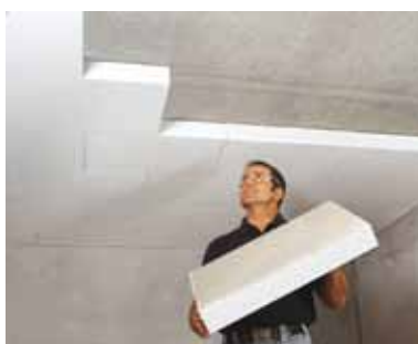
Ytong Multipor kan let og præcist tilpasses med almindeligt håndværktøj
