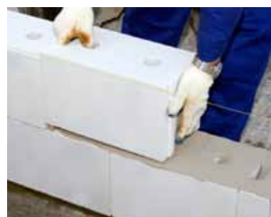
Montage af Silka planblokke sker let med de ergonomiske håndtag.
